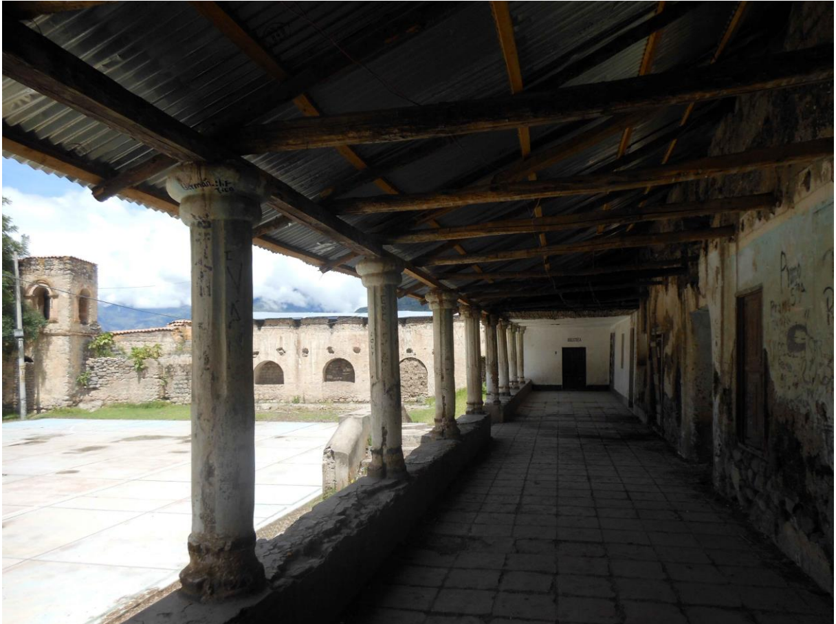
Galería de la casa principal de la hacienda Patibamba en Abancay. Al fondo y a la izquierda, la torre campanario de la capilla. Imagen: Samuel Amorós, 2016.
