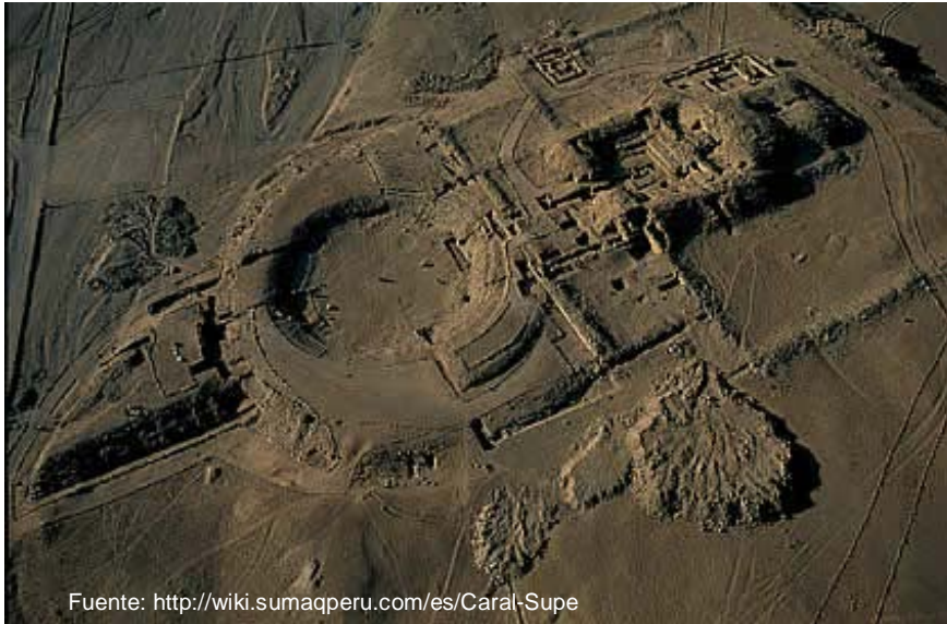
Figura 38. Edificio del Anfiteatro. Vista hacia el sureste.
