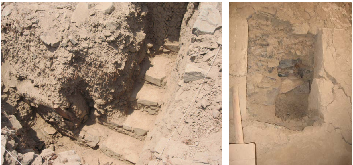
Figura 74. Detalles. a) Escalera de ingreso frente norte. b) Vano sellado en recinto del "forado", interior de las plataformas.
