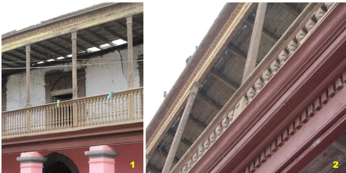
San Luis de Cañete, “casa de la colonia china”. 1. Detalle de la galería del segundo piso con pilarotes o pies derechos para sustentar la cubierta. 2. Detalle arquitectónico del diseño de los entablamentos, la balaustrada y las vigas o cuarterones con el entablado que cubre la galería. Imágenes: Sandra Negro, 2014.
