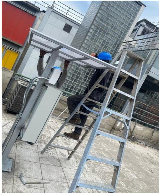
Colocación de techo de policarbonato para tablero de control de riego en la Facultad de Biología
