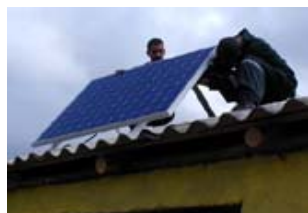
Instalación de panel fotovoltaico.
