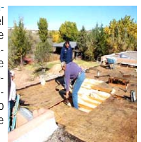
Construcción vivienda en adobe
