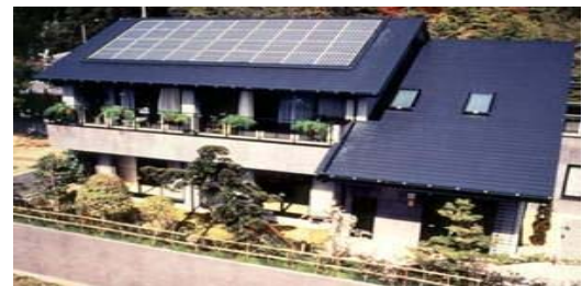
Paneles Fotovoltaicos integrados a techos.
