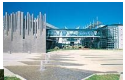
Oficinas Holcim S.A
