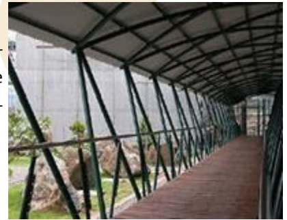
Oficinas Holcim S.A
