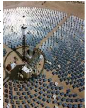
Central Solar de Almería, España
