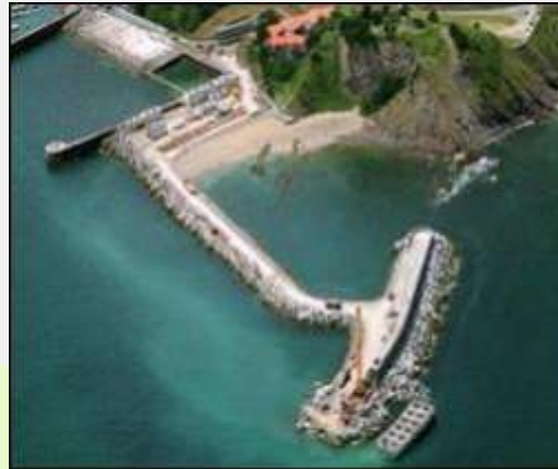
Vista aérea de la planta
