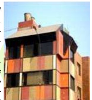
Edificio en Miraflores con paneles
