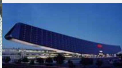
Edificio Sanyo (Paneles solares)
