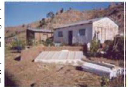
Sistema Calefactor Horizontal- "Piso Trombe"
