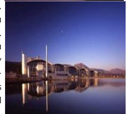
Edificio de Cristalería Chile
