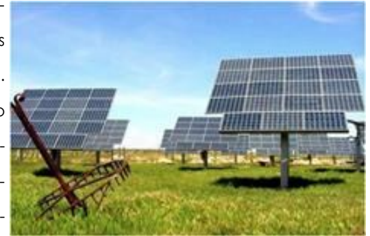
Paneles soales perpendiculares a los rayos solares
