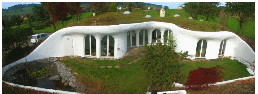
Fotografía de la Casa de la Tierra
