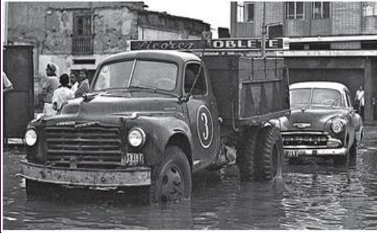
Inundaciones en carreteras
