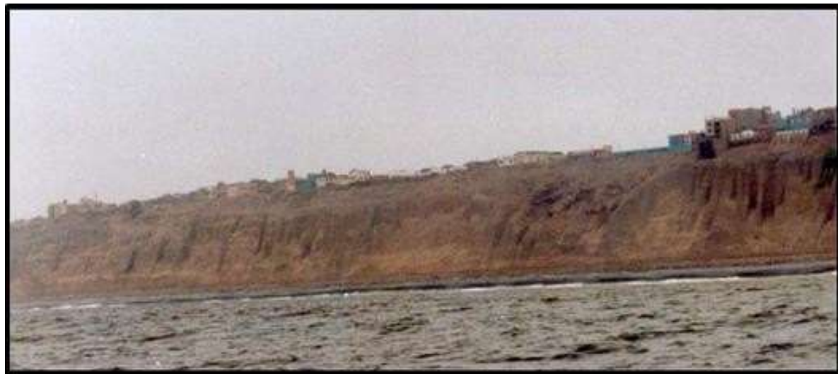
Figura 3: Vista panorámica del tramo
