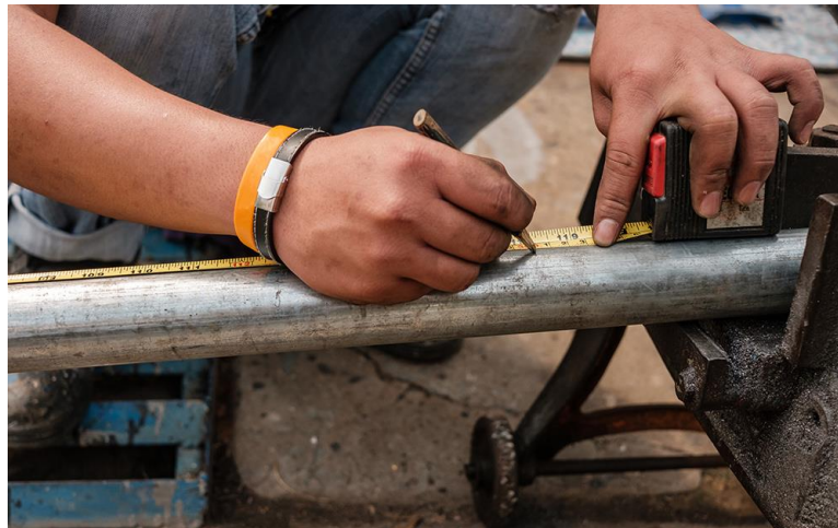
Figura 2: Marcado de tubo
