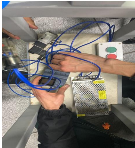
Figura 27: Corrección del Cableado
