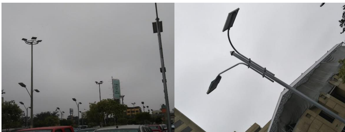
Imagen No.7: Pastorales de acero con luminarias fotovoltaicas en estacionamiento Campus URP. Elaboración propia.
