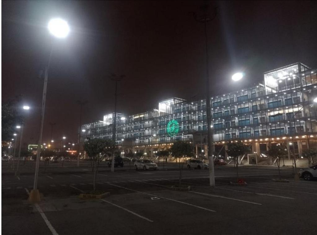
**Imagen No.8: Pastorales de acero con luminarias fotovoltaicas (noche) en estacionamiento Campus URP.**
