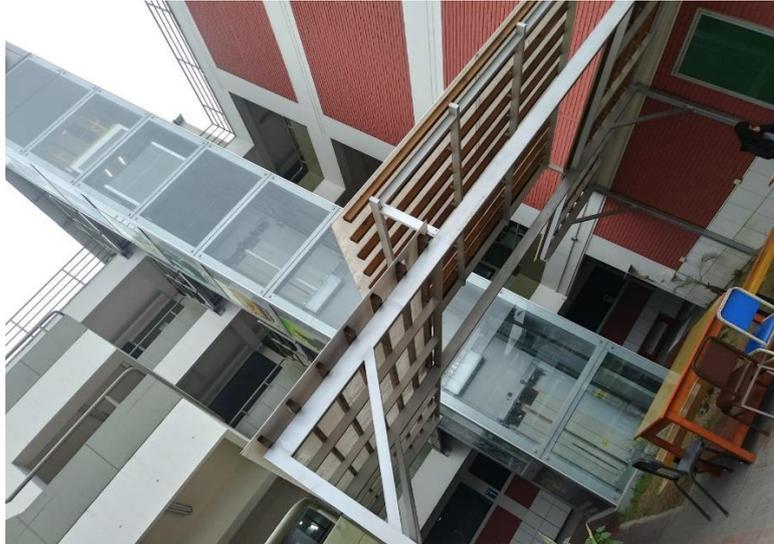
Imagen No.14: Estructura de acero con policarbonato zona libre para estudiantes.
