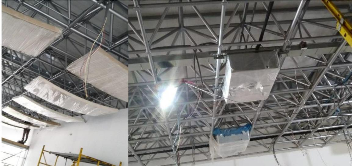
**Imagen No.12: Paneles acústicos instalados.** Elaboración propia.
